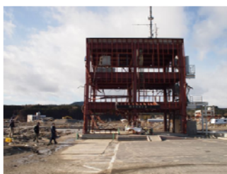
南三陸町防災庁舎跡（取壊し予定）
